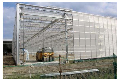
《栽培施設の建設現場》
