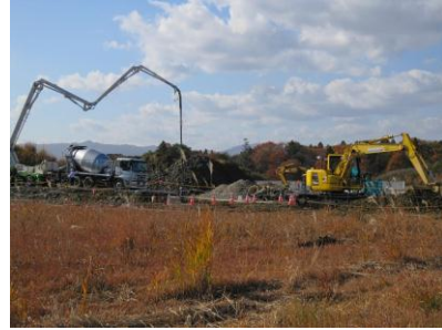
《新工場建設現場》
