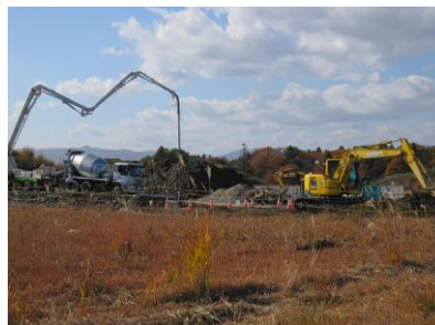
《新工場建設現場》
