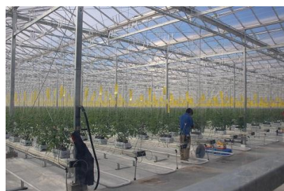
《完成した栽培施設》
