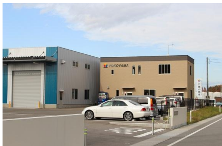
《完成した新事務所》
