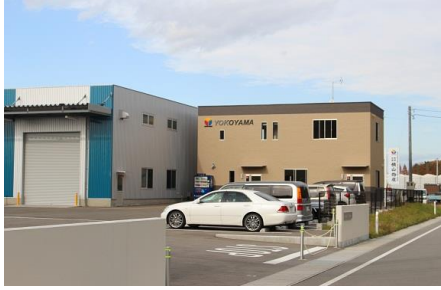
《完成した新事務所》
