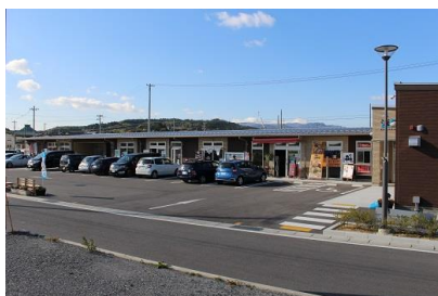
《商業施設の全景》
