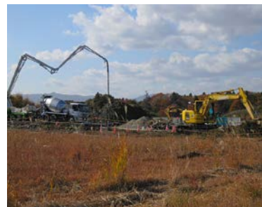
《E 社新工場建設現場》
