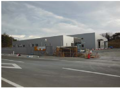
《新工場建設現場》
