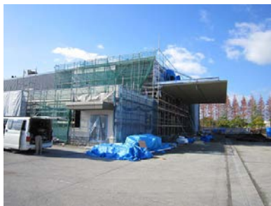
《D 社新工場建設現場》
