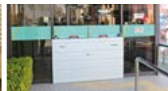
台風19号の被害後、防水板を設置
